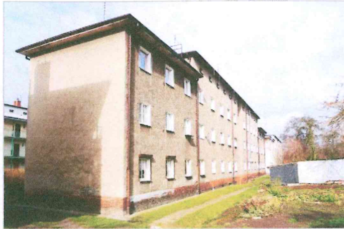
Fot. nr 2. Widok budynku od strony podwórza.
