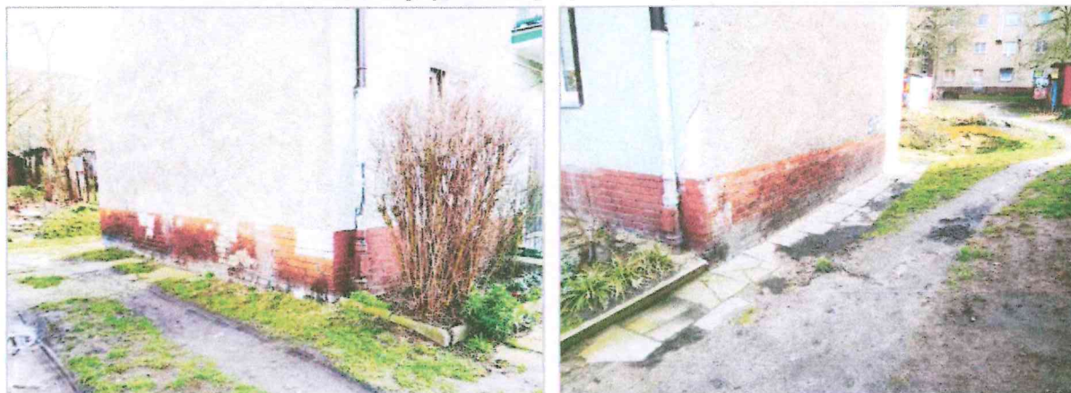
Fot. nr 13, 14. Ściany szczytowe (płn. i płd.) – silne zawilgocenie, zniszczone betonowe opaski, niekorzystne ukształtowanie terenu przy ścianie południowej, spadki w kierunku budynku – zastoiska wody opadowej.
