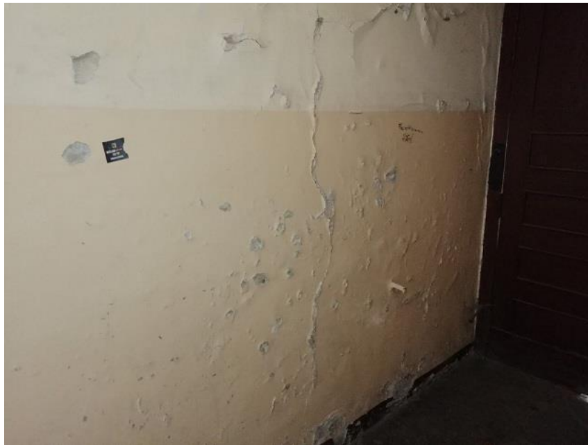
Fot. 14 Uszkodzenia ścian (zaprawa murarska)
