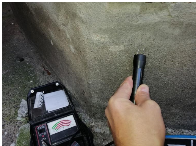
Fot. 7 pomiar wilgotności pod blachą
