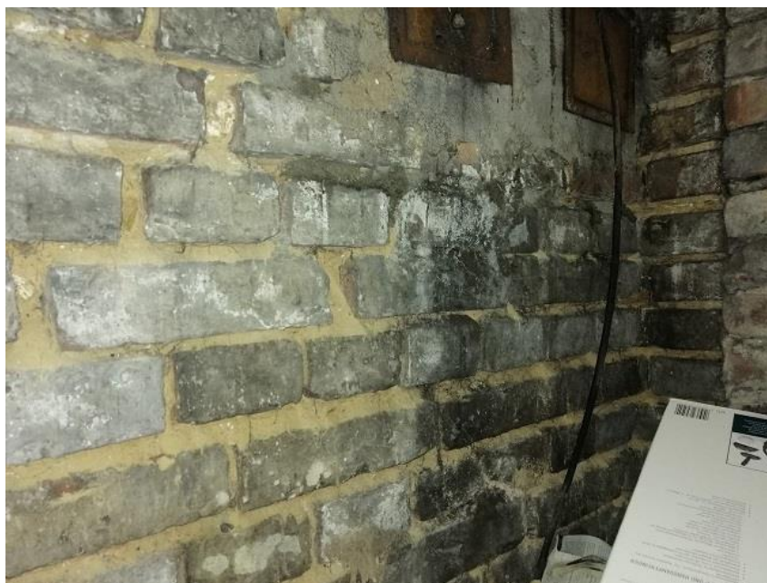
Fot. 14 Uszkodzenia ścian (zaprawa murarska)
