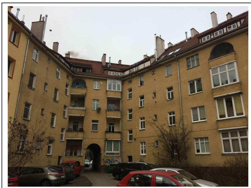
Widok ogólny na elewacje tylne budynku
