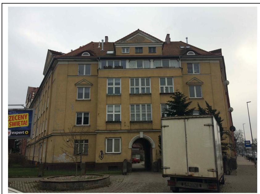
Widok ogólny elewacji od strony narożnika
