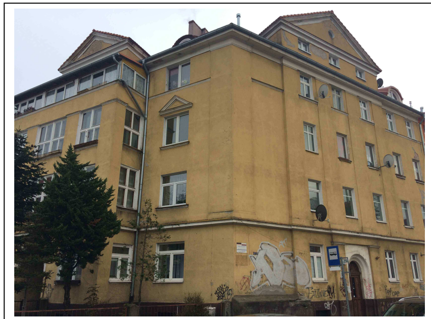
Widok ogólny elewacji narożnika od strony al. Bohaterów Warszawy
