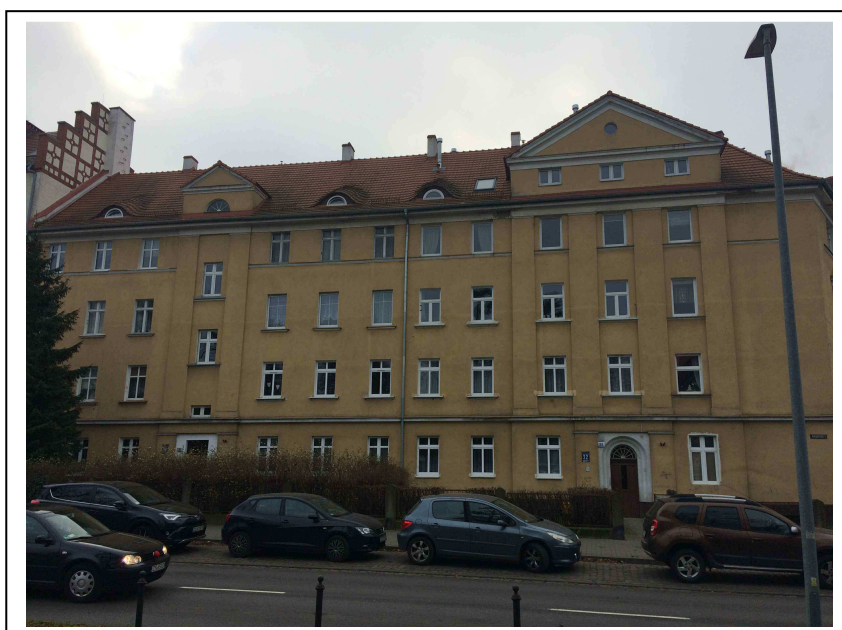
Widok ogólny elewacji narożnika od strony ul. Mickiewicza nr 22 i sąsiednią nr 20
