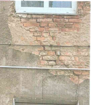
14 Ubytki w spoinach muru, ubytki cegieł i spękania.
