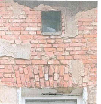
5 Widoczne pęknięcia muru nad nadprożem okna oraz ubytki spoinowania w nadprożu.
