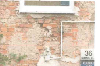
10 Ubytki w murze nad drzwiami wejściowymi.
