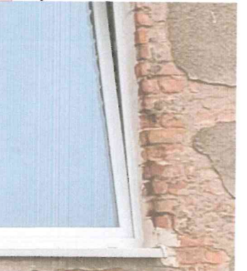
10 Ubytki w murze nad drzwiami wejściowymi.
