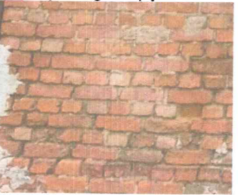
14 Ubytki w spoinach muru, ubytki cegieł i spękania.
