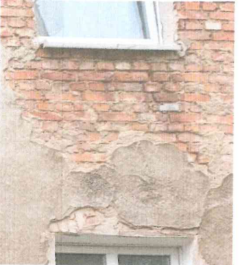
5 Widoczne pęknięcia muru nad nadprożem okna oraz ubytki spoinowania w nadprożu.
