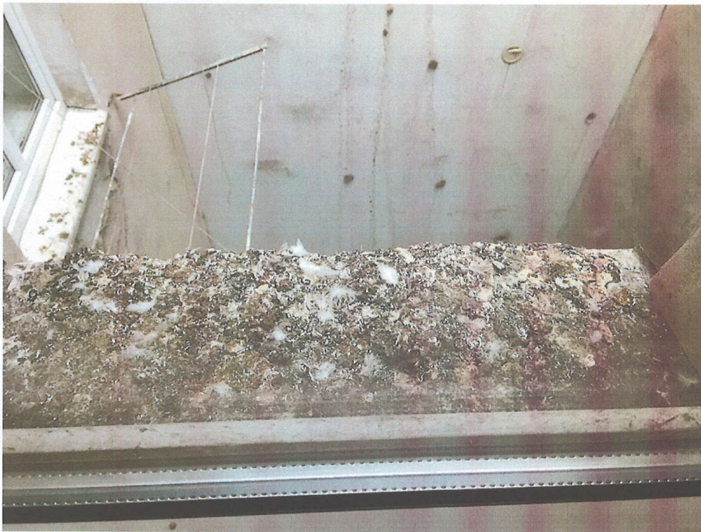
Fot. 2. Parapet okienny we wschodniej wnęce.
