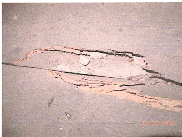
Podłoga z desek w części strychowej zniszczona przez szkodniki drewna.
