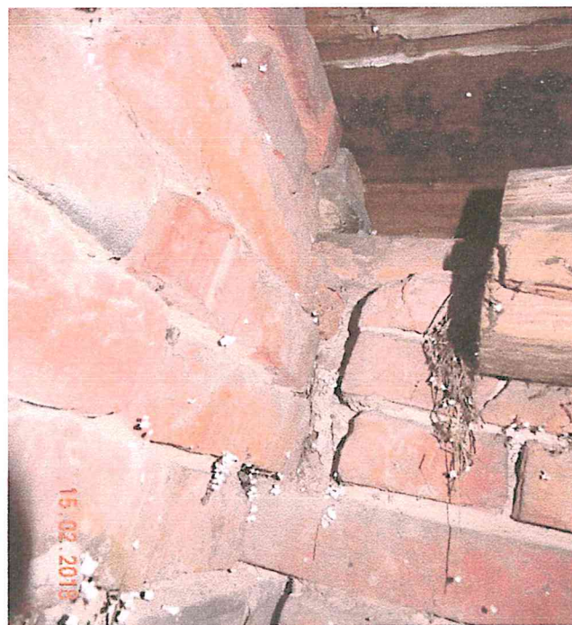
Widok przedmiotowej ściany od wewnątrz, mur przewiązany co trzecią warstwę
