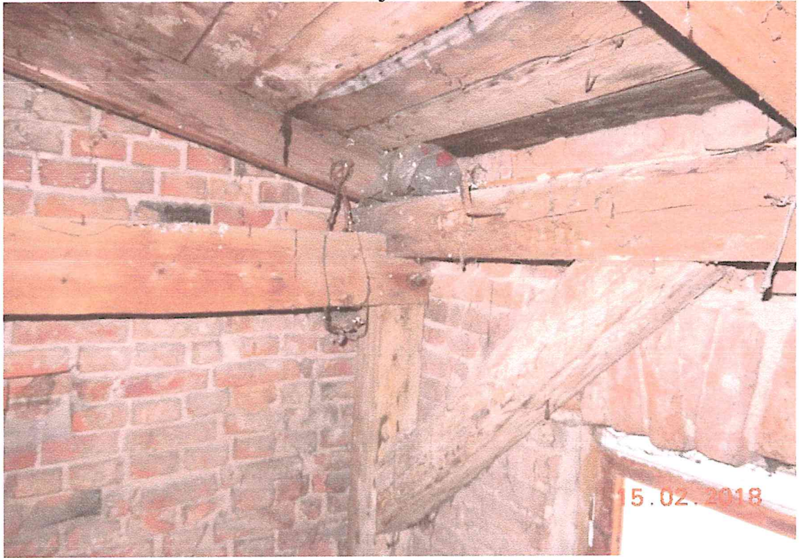
Konstrukcja dachu w stanie technicznym średnim (po naprawach doraźnych) Nie zastosowano łączników ciesielskich.
