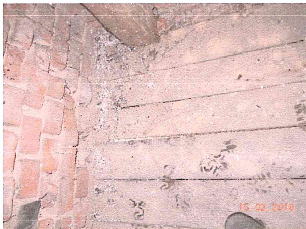
Podłoga z desek w części strychowej zniszczona przez szkodniki drewna.
