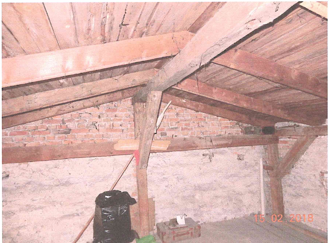
Konstrukcja dachu w stanie technicznym średnim (po naprawach doraźnych) Nie zastosowano łączników ciesielskich.
