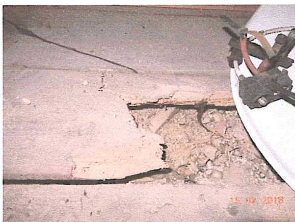
Podłoga z desek w części strychowej zniszczona przez szkodniki drewna.
