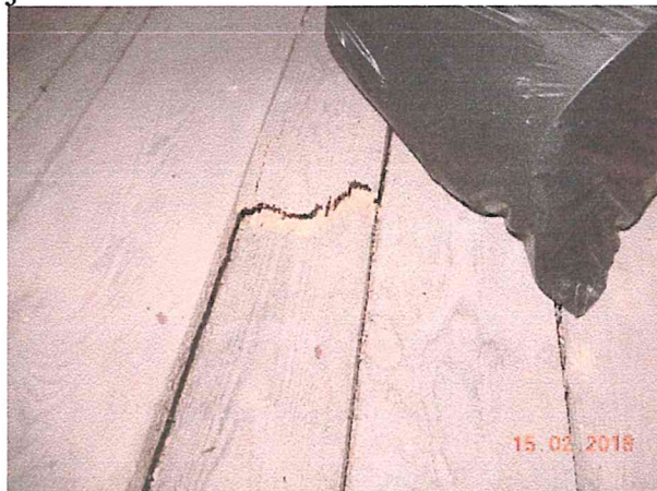
Podłoga z desek w części strychowej zniszczona przez szkodniki drewna.
