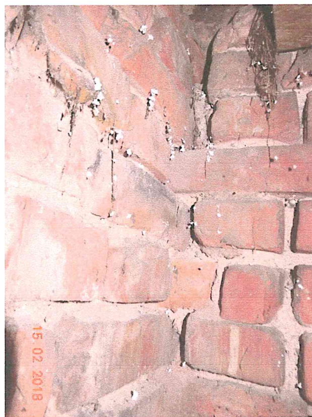
Ubytki spoin w murze ceglany, niedokładności wykonawcze
