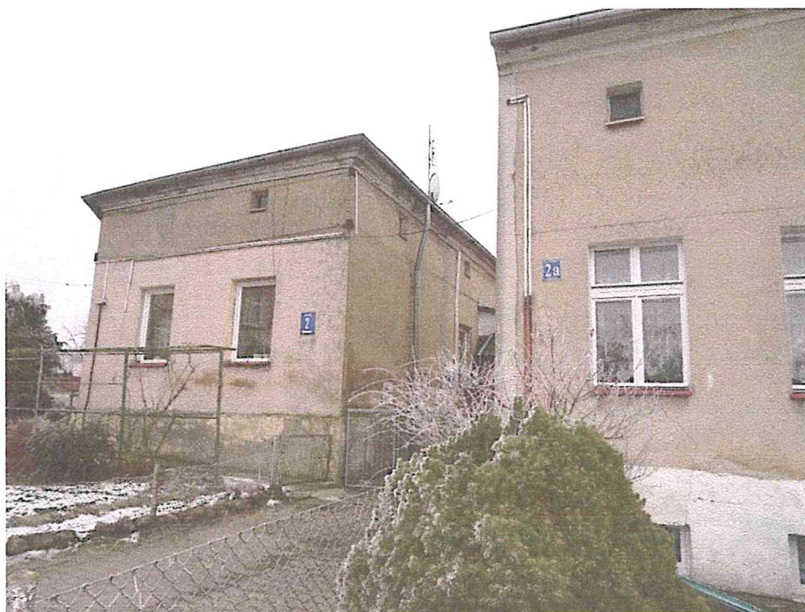
Widok elewacji przedmiotowych budynków.
