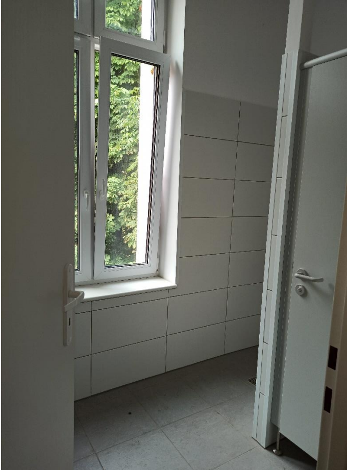
al. Wyzwolenia 7/U15 II piętro
