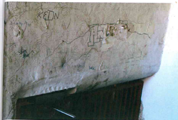
fol.1 nadproże nad wejściem do klatki schodowej
