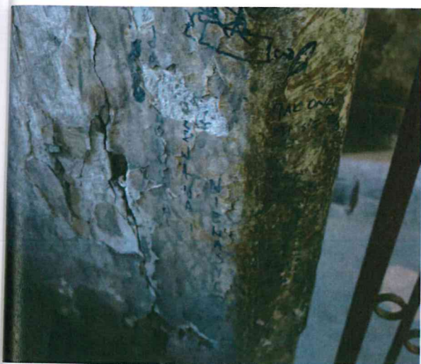
fol.2 ściana przy wejściu do klatki schodowej
