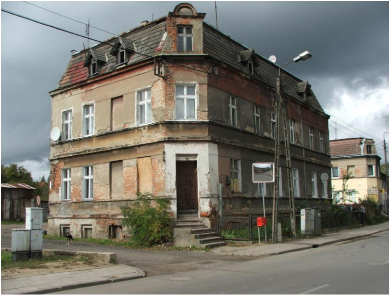
FOT.1 Elewacja frontowa
