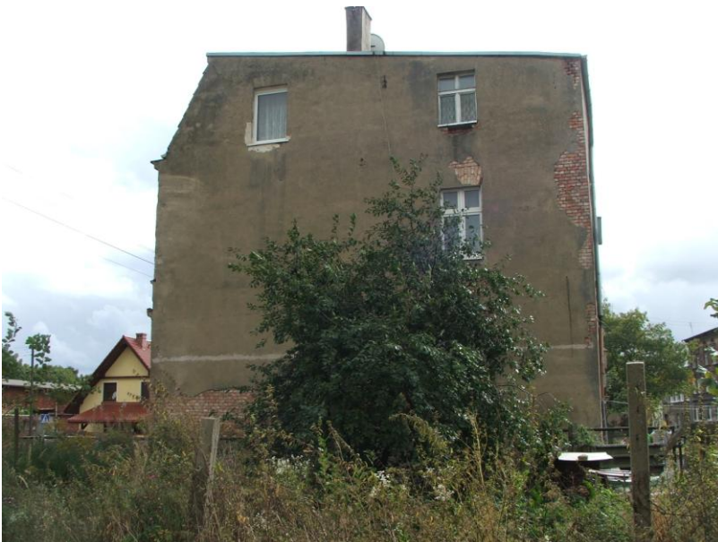
FOT.3 Elewacja boczna
