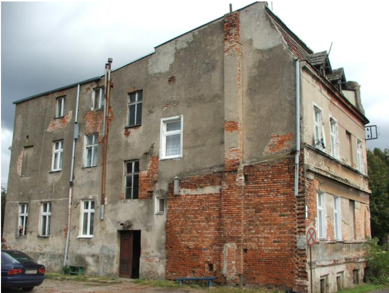
FOT.2 Elewacja tylna
