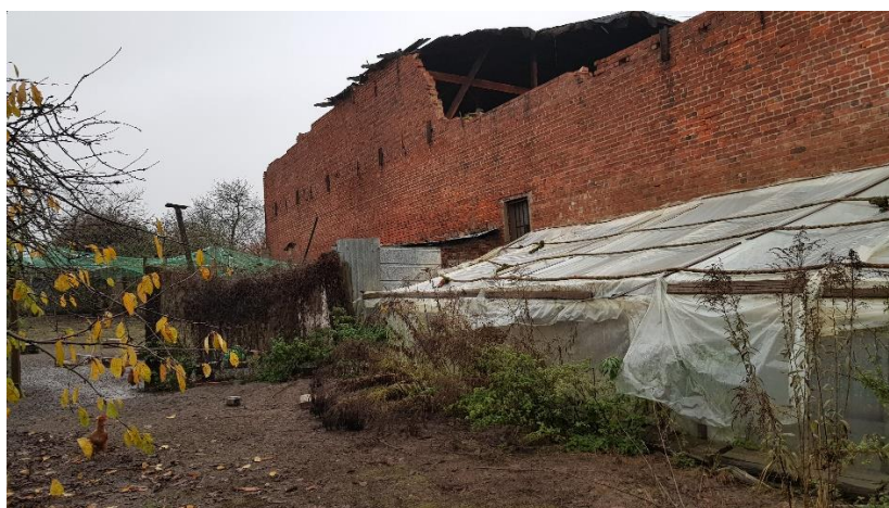
Fot.nr 10. Widok ściany tylnej – elewacja południowa – destrukcja części murów zewnętrznych. Widoczne tymczasowe namioty foliowe – brak namiotów foliowych w ewidencji geodezyjnej oraz administracyjnej.
