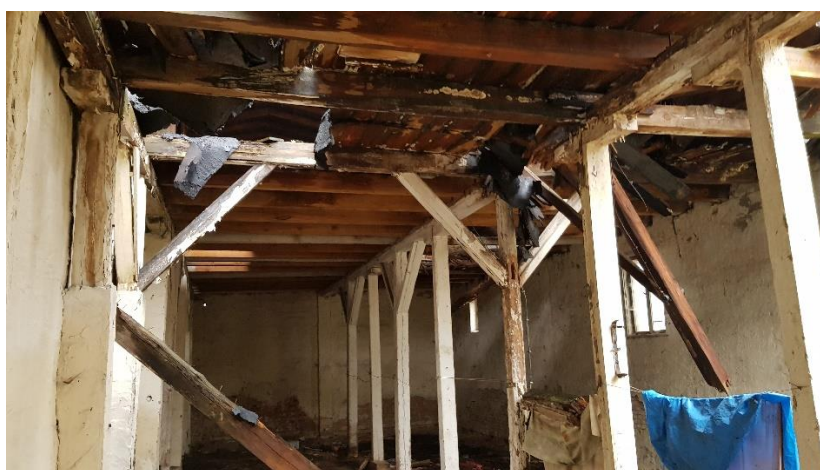
Fot.nr 14. Widok wnętrza budynku użytkowego – destrukcja konstrukcji stropów.
