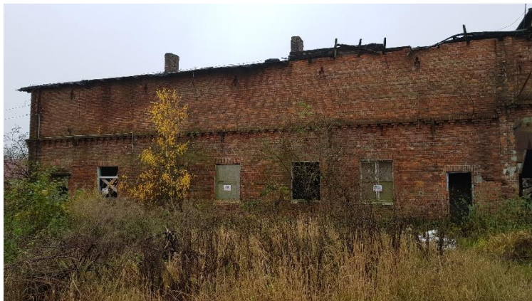
Fot.nr 4. Widok frontu budynku użytkowego – widoczne zniszczenie części pokrycia-okap oraz uszkodzenia strefy gzymsowej ,
