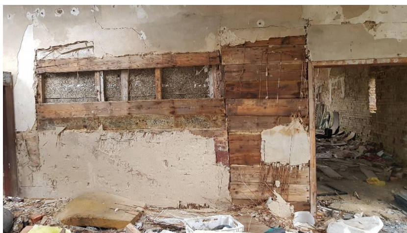
Fot.nr 15. Widok wnętrza budynku użytkowego – destrukcja konstrukcji ścian działowych klatki schodowej.
