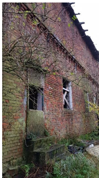
Fot.nr 4. Widok frontu budynku użytkowego – widoczne zniszczenie części pokrycia-okap oraz uszkodzenia strefy gzymsowej ,
