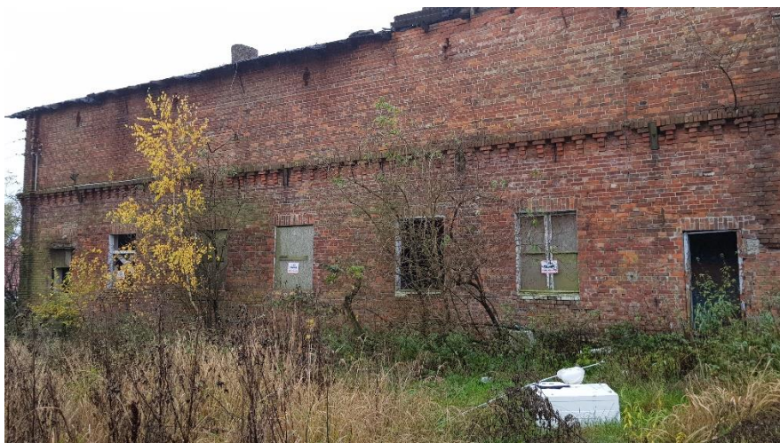
Fot.nr 3. Widok frontu budynku użytkowego – zniszczenie części gzymsu ściany oraz pokrycia dachowego, częściowy brak stolarki okiennej oraz szklenia.
