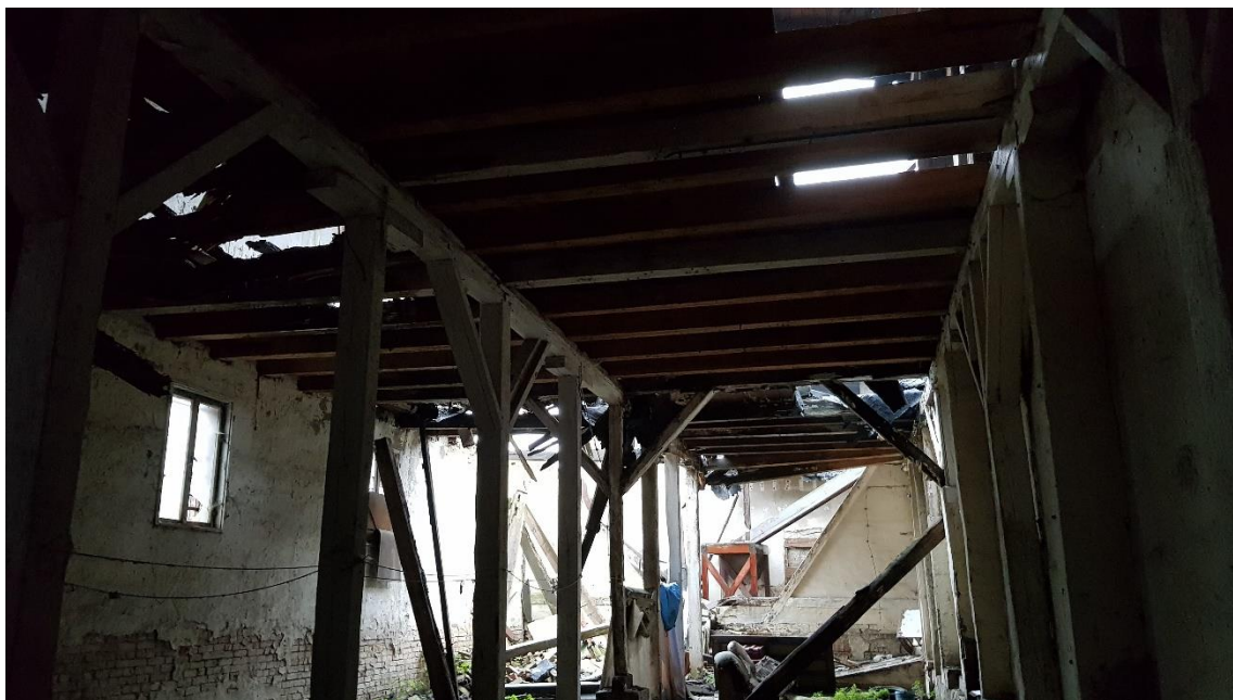
Fot.nr 16. Widok wnętrza budynku użytkowego – destrukcja stropu belkowego.
