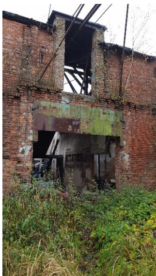
Fot.nr 4. Widok frontu budynku użytkowego – widoczne zniszczenie części pokrycia-okap oraz uszkodzenia strefy gzymsowej ,
