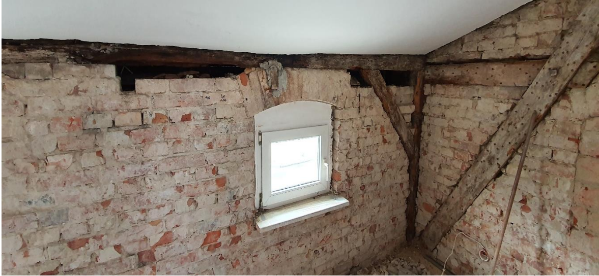
Skorodowana, zniszczona struktura słupków, oczepów i zastrzałów
