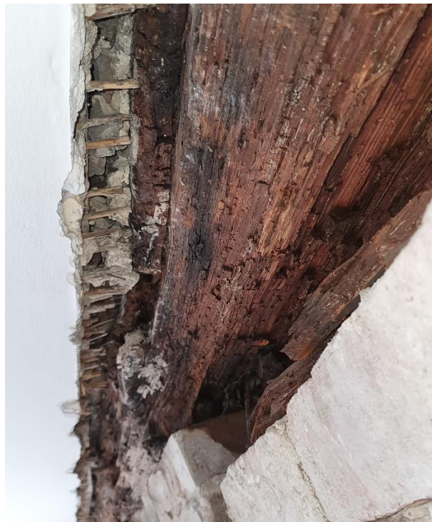
Belka oczepu, uszkodzona, skorodowana , zniszczony przekrój
