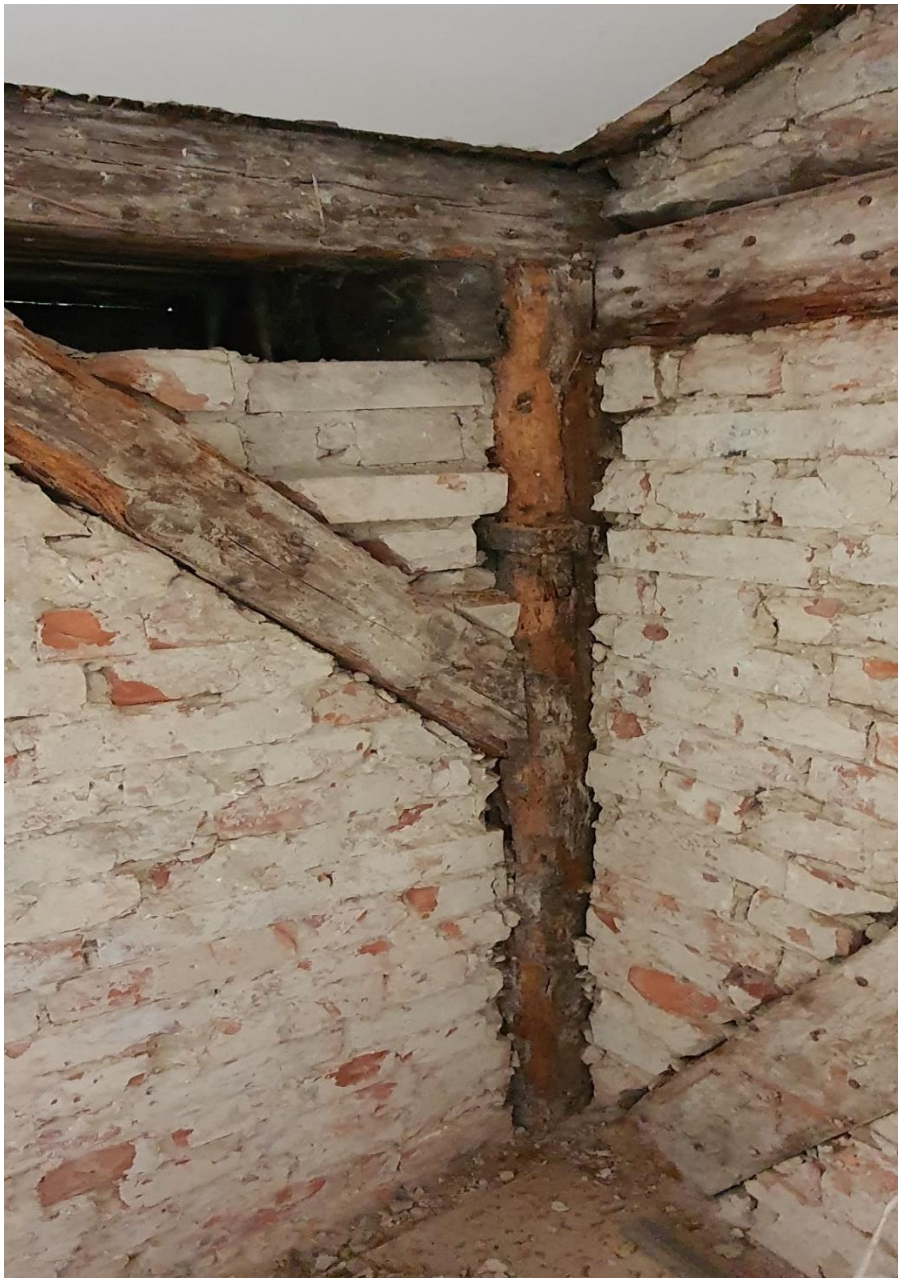
Skorodowana, zniszczona struktura słupków, oczepów i zastrzałów
