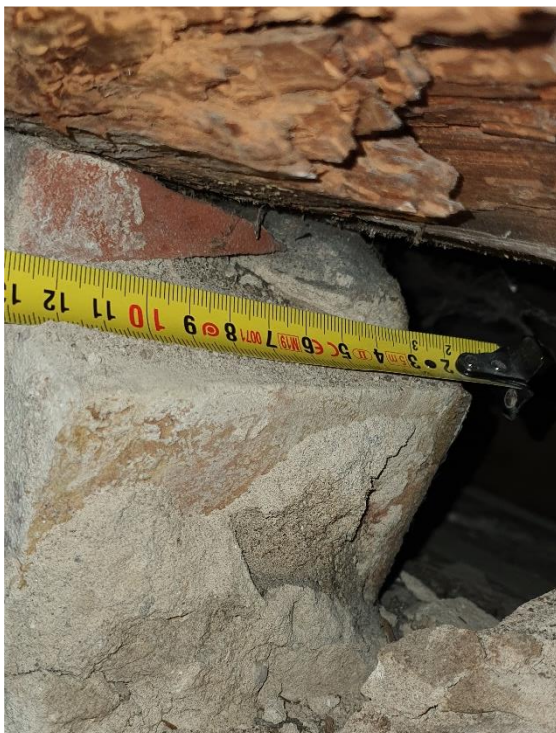
Belka oczepu, uszkodzona, skorodowana , zniszczony przekrój
