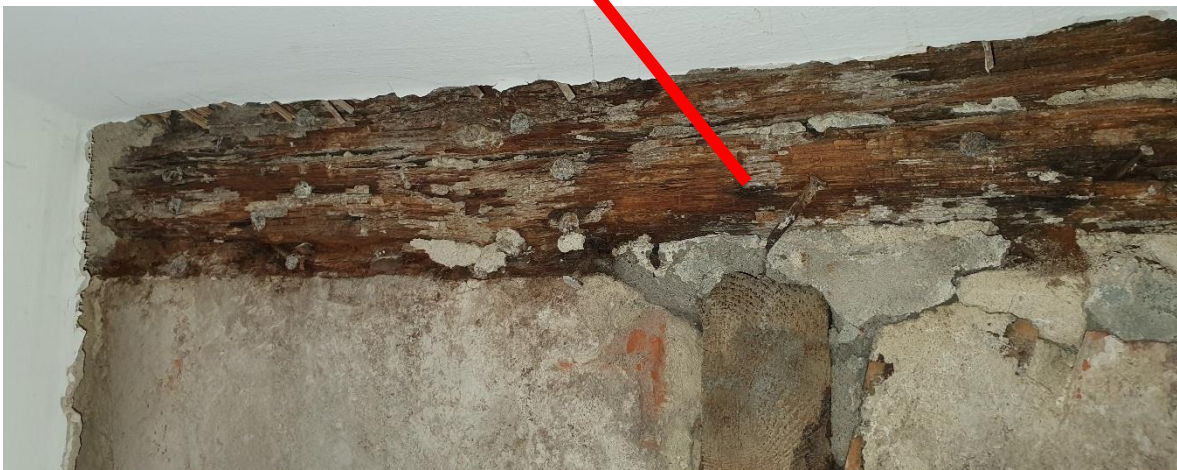
Belka oczepu, uszkodzona, skorodowana , zniszczony przekrój
