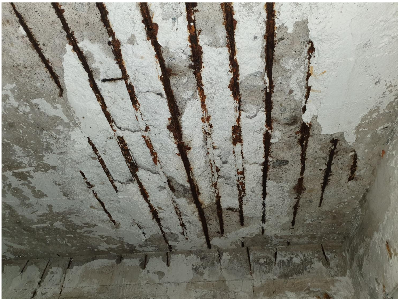
Widoczne skorodowane pręty zbrojenia stropu i podciągów
