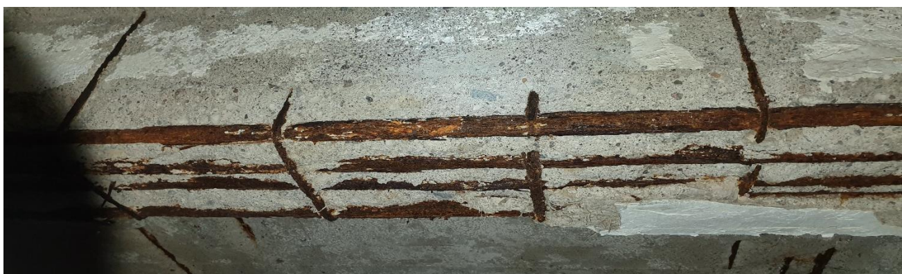
Skorodowana stal zbrojeniowa wskutek uszkodzenia otuliny
