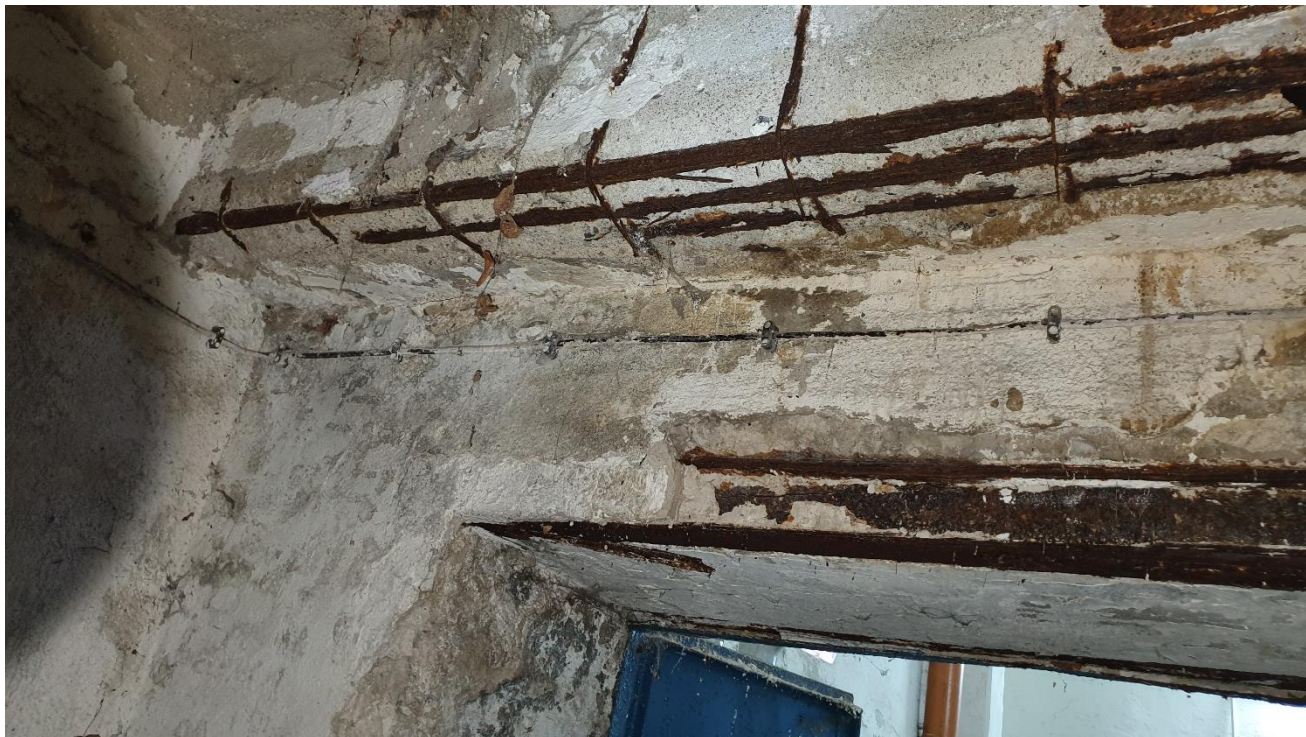
Widoczne skorodowane pręty zbrojenia stropu i podciągów
