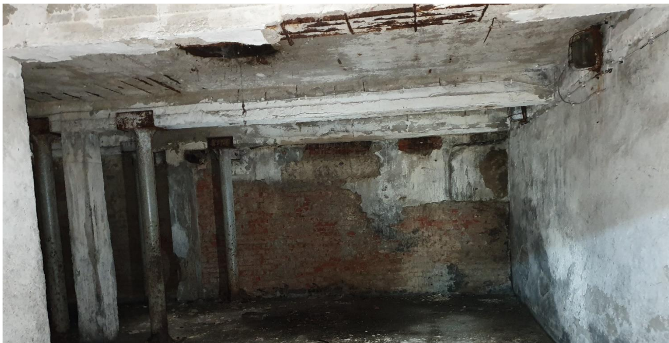
Skorodowana stal zbrojeniowa wskutek uszkodzenia otuliny
