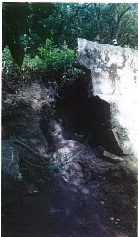
Zdj. nr 1 – Mur oporowy w południowej części
