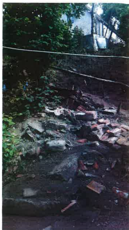
Zdj. nr 2 – Pozostałości po murze oporowym w północnej części
