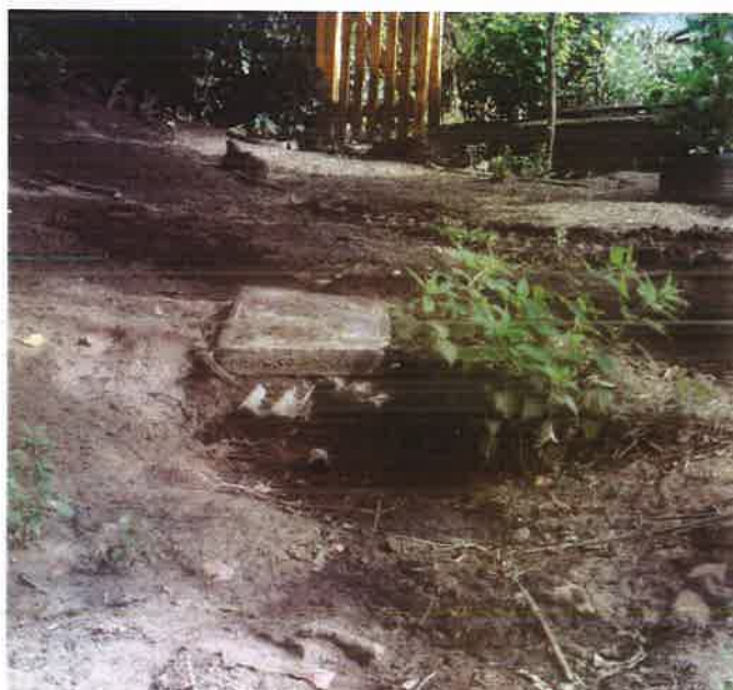
Zdj. nr 3 – Wylot rury odprowadzającej wodę
