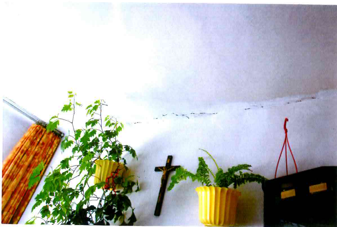
Fot. 14. Rysa w suterenie wskazująca na odchodzenie ściany szczytowej od stropu
