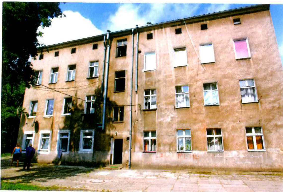
Fot. 5. Ujęcie zbliżone elewacji podwórzowej
