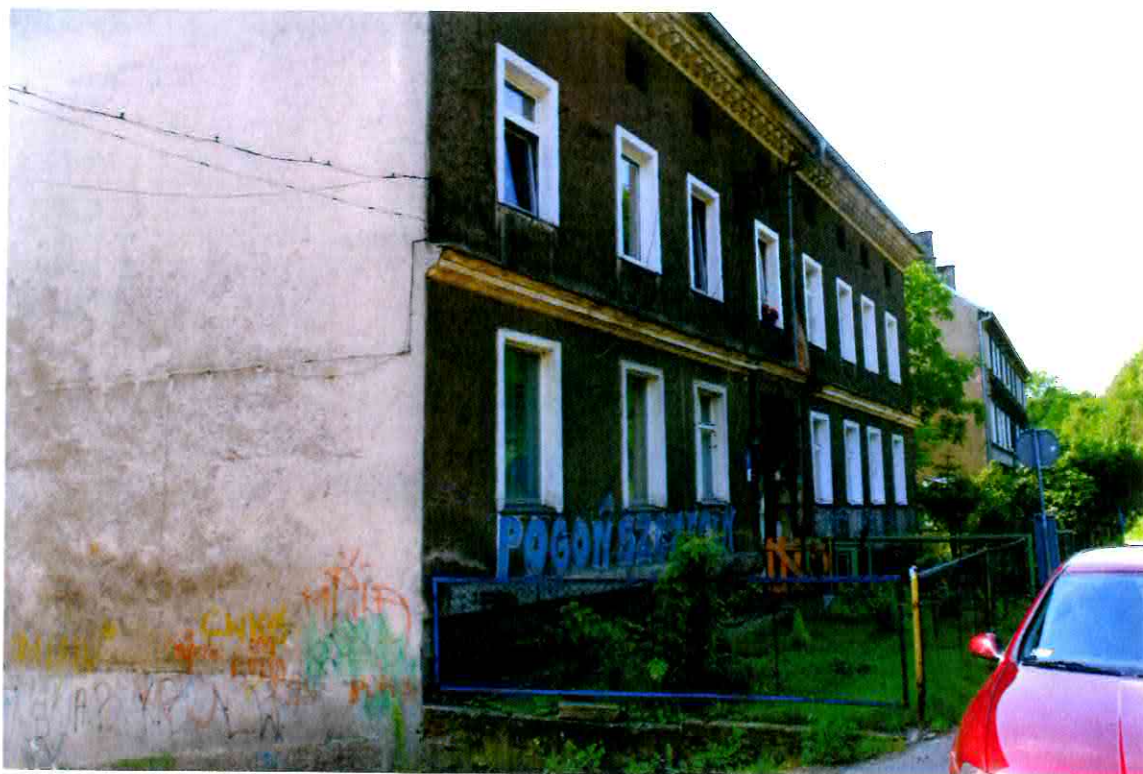
Fot. 1. Front budynku nr 14 od strony ulicy Lipowej
