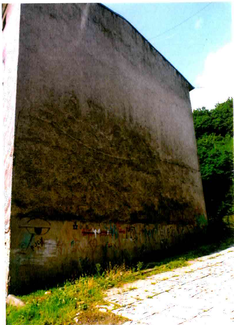
Fot. 2. Lewa ściana szczytowa patrząc na budynek od strony frontu
