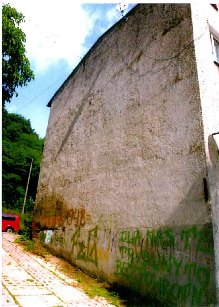
Fot. 4. Ściana szczytowa w zbliżeniu
