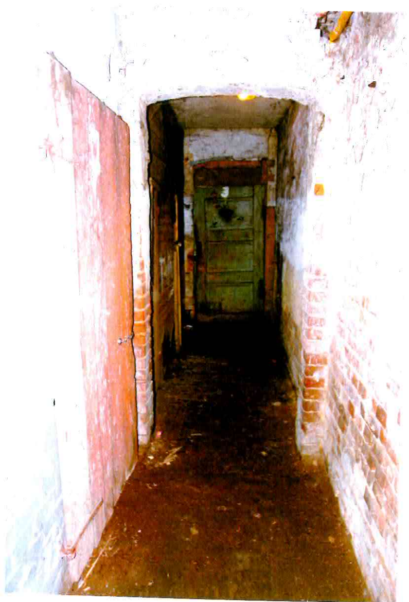
Fot. 16 i 17. Piwnice przylegające do sutereny
