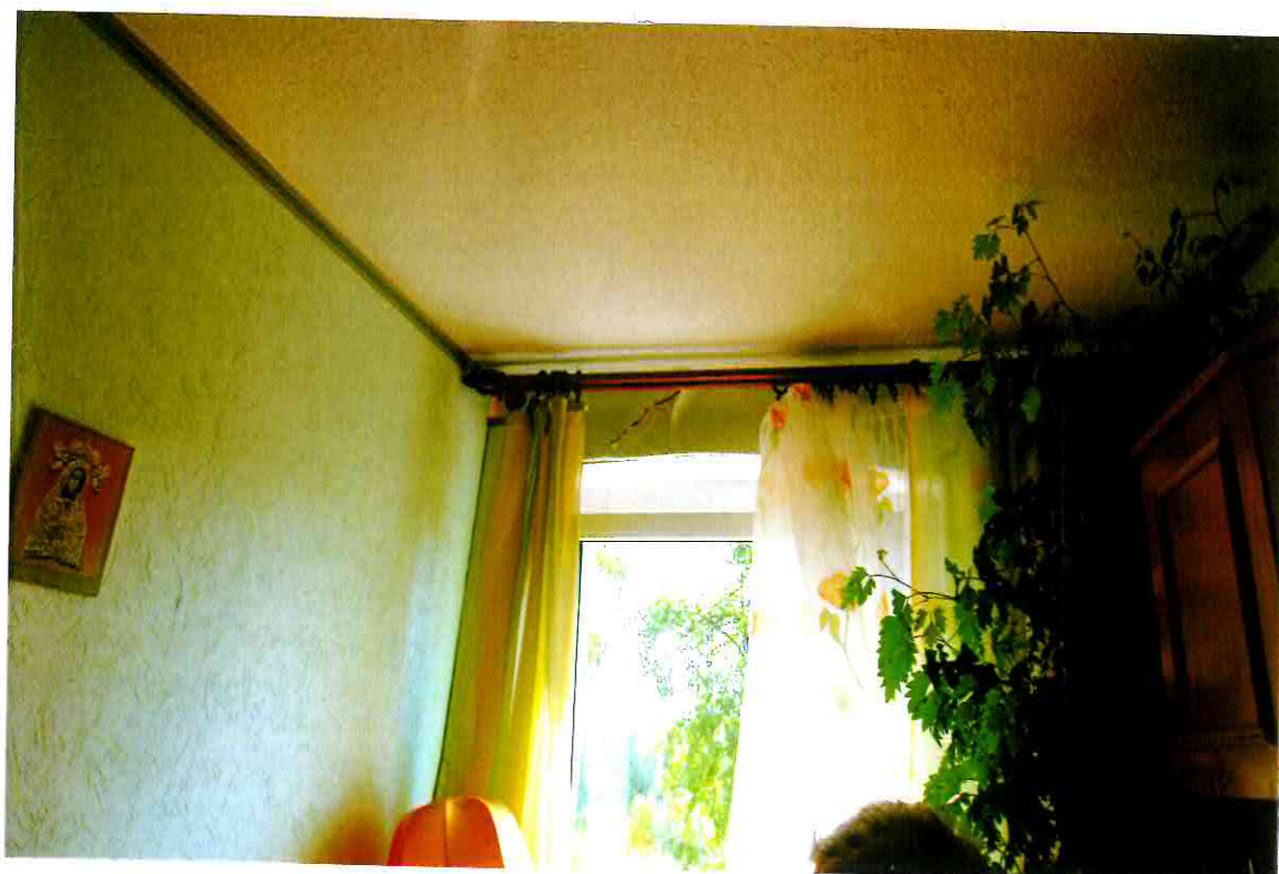
Fot. 14. Rysa w suterenie wskazująca na odchodzenie ściany szczytowej od stropu
