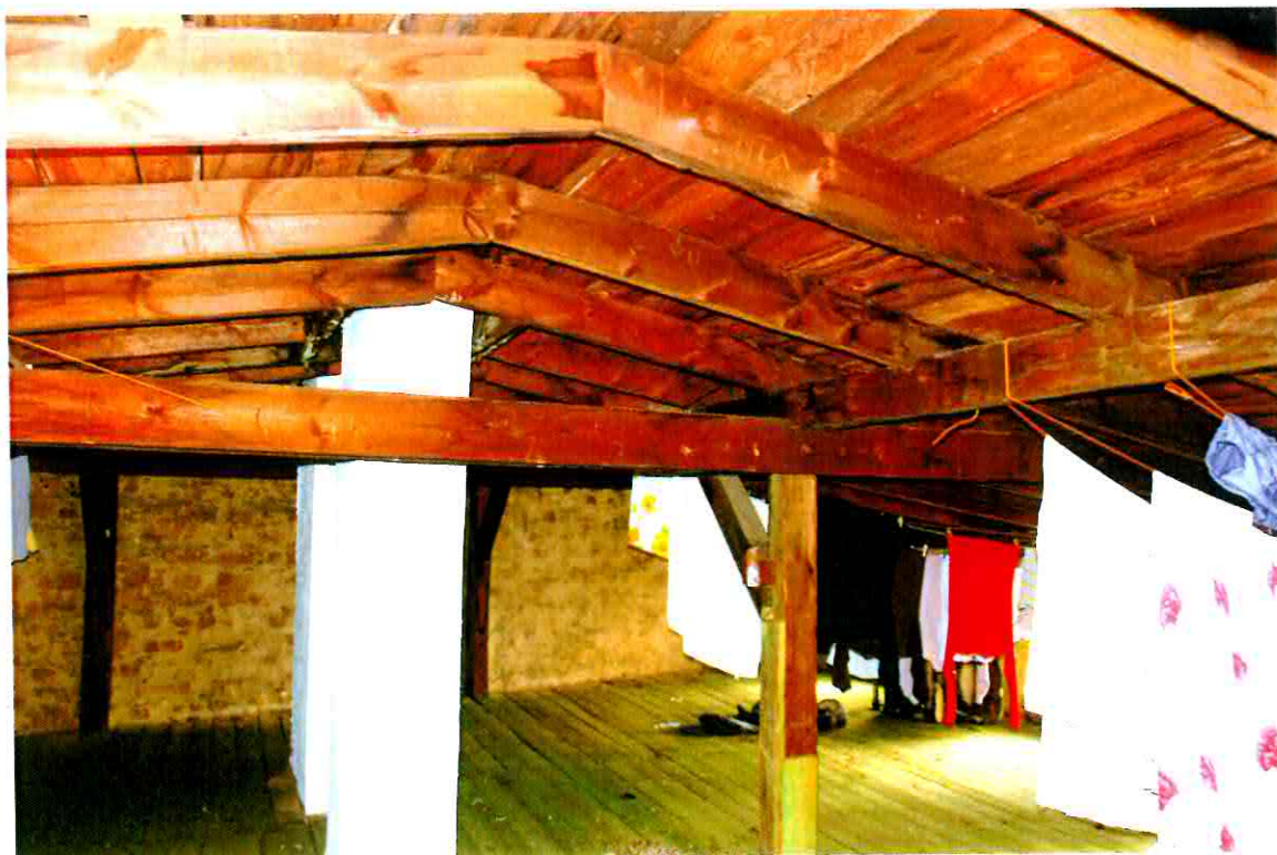
Fot. 20,21. Korzystny stan konstrukcji dachowej i zadowalający stan podłogi strychowej
