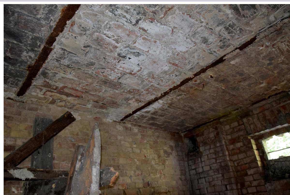
WNĘTRZE BUDYNKU - WIDOK STROPU
