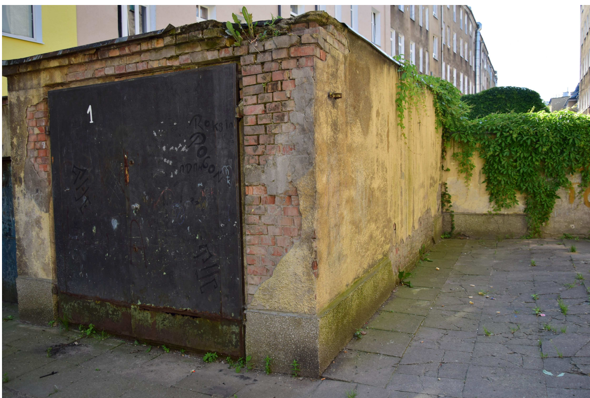
WIDOK OD STRONY PÓŁNOCNO-WSCHODNIEJ
