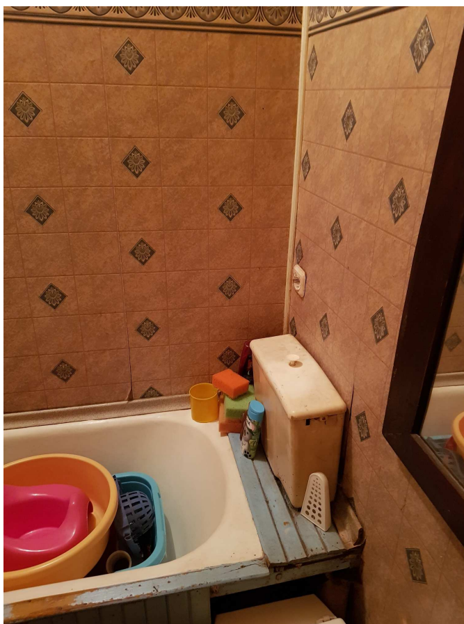
Zdjęcie 1: łazienka, po prawej stronie nad wanną znajduje się gniazdo
