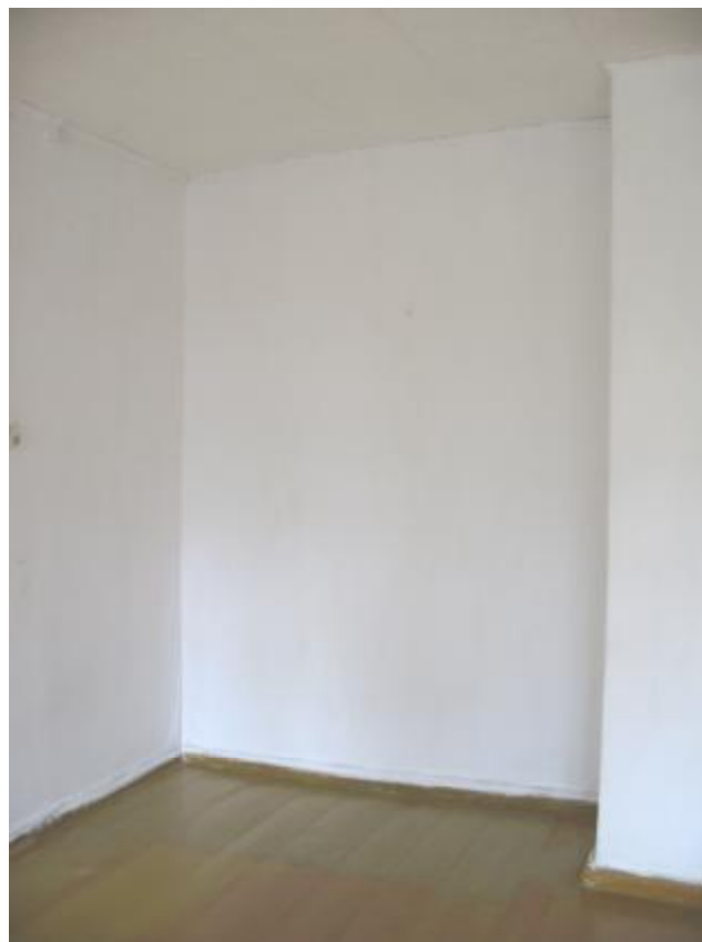
Widok ścianki drewnianej do rozbiórki i do wykonania otworu drzwiowego.
